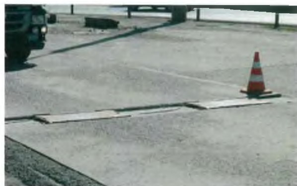
б) Установка ГПУ систем в приямок
